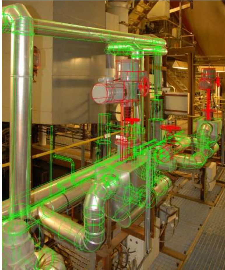
Bild 7: Bestandsaufnahme in einem HKW
