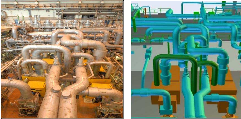
Bild 6: Details eines Versorgungsleitungssystems
